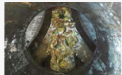
Blick in einen Abwasserschacht mit Küchenabfällen.
